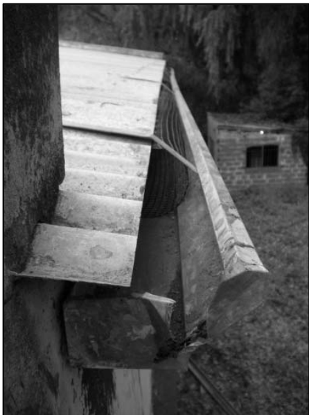
UNA DE LAS CANALETAS DEL TECHO
